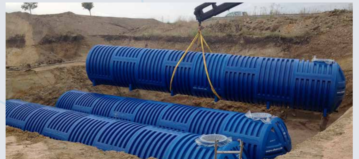
(Einbau Aqua'Terne 204-Batterie „Löschwassertank“)
