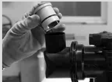
Schritt 18- Entlüftungsstopfen Ø42 11 in den Entlüftungswinkel Ø 70mm 8 einklipsen
