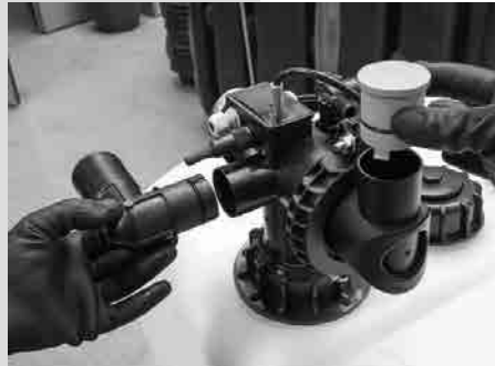
Schritt 16-Entlüftungswinkel (Durchmesser Symbol) 42mm ⑦ min. waagrecht montieren.
