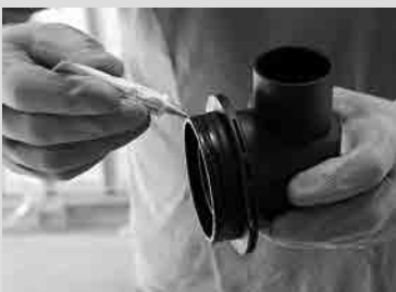
Schritt 13- O Ring am Entlüftungswinkel Ø 70mm 8 leicht einfetten 6
