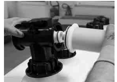
Schritt 8- Erweiterungsrohr 15 in die Erweiterung 14 einklipsen
