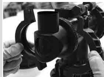
Schritt 15- Entlüftungswinkel Ø 70mm 8 an der Erweiterung 14 mit Schellen 9 befestigen
