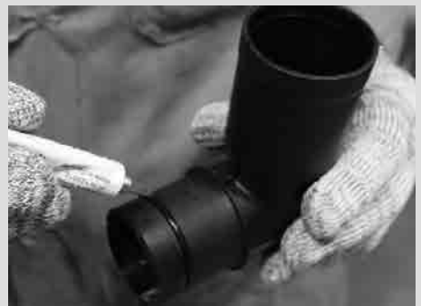
Schritt 6- O Ring am Entlüftungswinkel Ø 42mm ⑦ leicht einfetten ⑥
