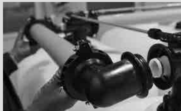
Schritt 6- Umlenkbogen 24 mit Erweiterungsrohr an die Erweiterungen mit Schellen und Schrauben befestigen
