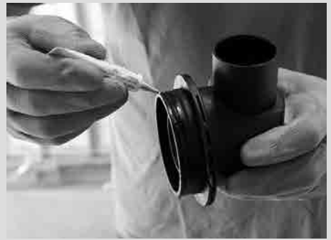
Schritt 9- O Ring am Entlüftungswinkel Ø 70 mm ⑧ leicht einfetten ⑥
