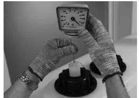
Schritt 23- Das Gewicht der mechanische Füllstandsanzeige in den Heizöl-Sicherheitstank langsam gleiten lassen Mechanische Füllstandsanzeige in der Überwurfmutter festschrauben
