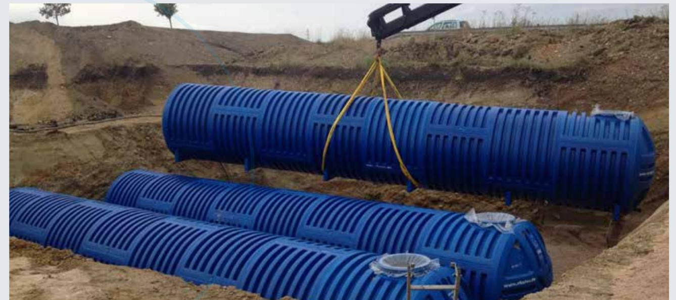
(Einbau Aqua'Terne 204-Batterie „Löschwassertank“)
