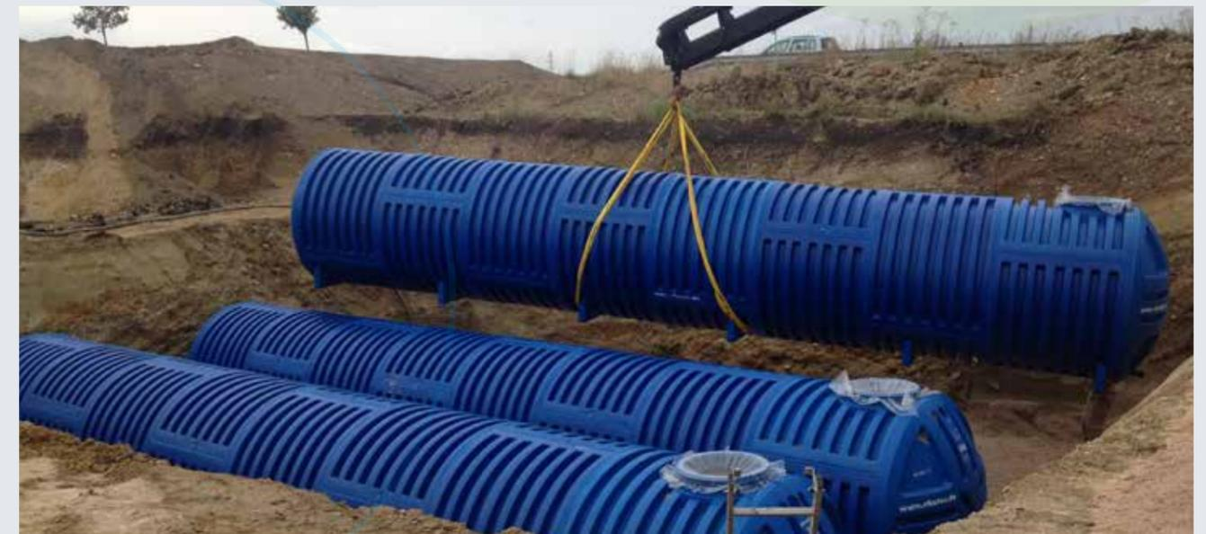
(Einbau Aqua'Terne 204-Batterie „Löschwassertank“)
